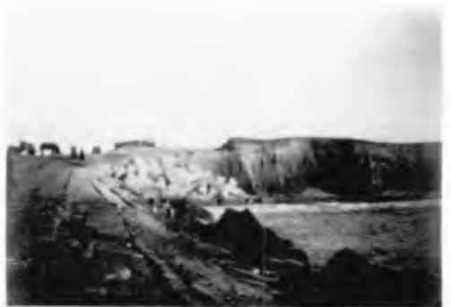
Fig. 9. Erosion on the leeside of groin I, Bovbjerg, 1895.
