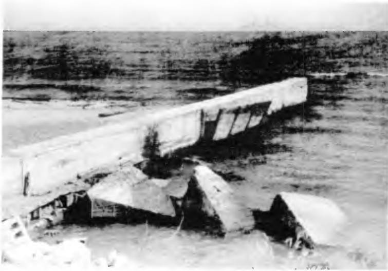
Fig. 11 Concrete groin.
