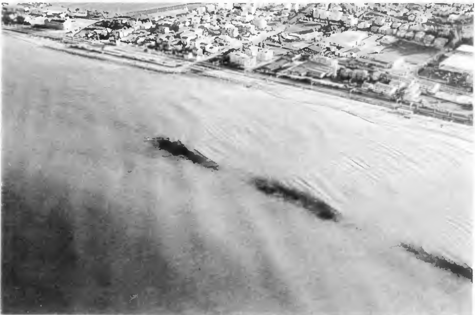
Fig. 7 – Protective system at Marina di Montemarcano (AN, Marche).
