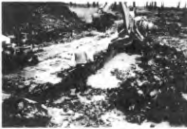
2a Backhoe clearing face of till
