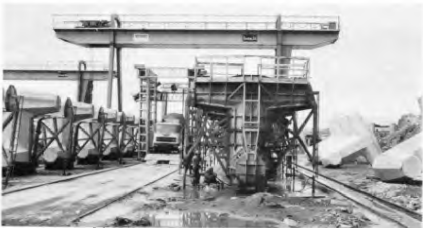
Fig. 8 Dolos moulds
