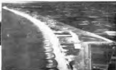
Fig. 39. Dutch group of groins, Walcheren (Rijkswaterstaat)
