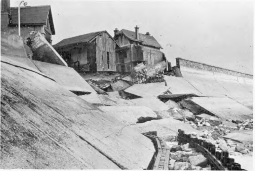
Photo N°1 - Perré de Cap-Breton
