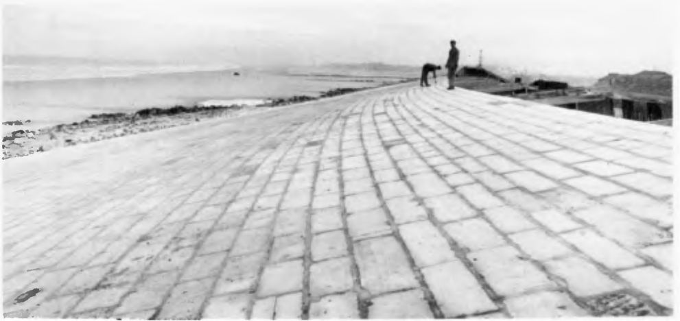
Fig. 37. Le perré côté mer.
