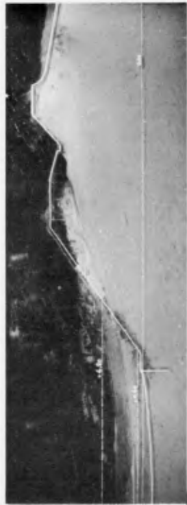
Fig. 12. 3ème phase - Le perré détruit, le sable flue rapidement et s'éboule dans le canal des waterings.
