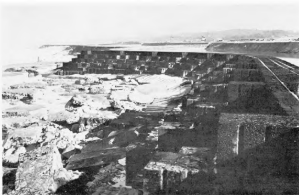
Photo N°6 - Nouveau brise-mer des Huttes construit vers 1935
