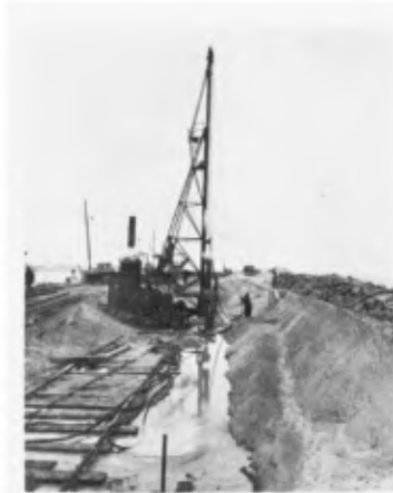
Fig. 32. Battage des palplanches du batardeau.
