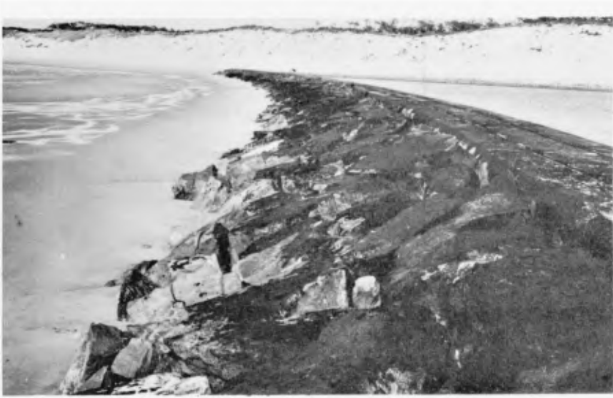
Photo N°7 - Nouveau brise-mer de l'Anse des Huttes (1952) Remplace le vieux brise-mer détruit (1853) Bon ensablement devant l'ouvrage (1954) Talus des enrochements 2/I
