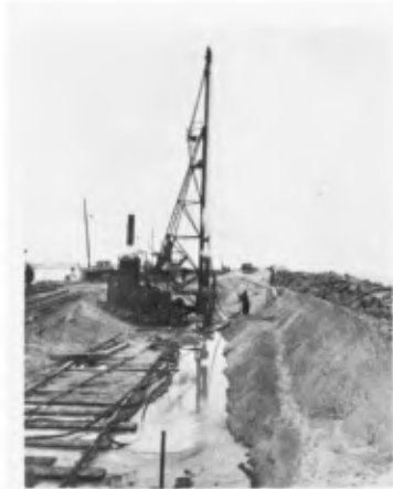
Fig. 32. Battage des palplanches du batardeau.
