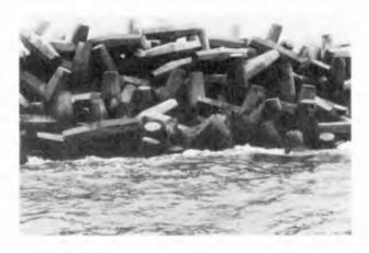
FIG.5 TYPICAL DOLOS BREAKAGE (4-TON UNITS AT STA 126+50)
