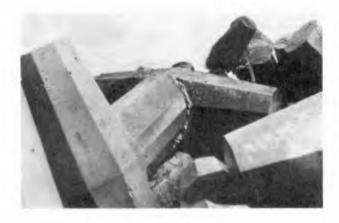
FIG.4 TYPICAL DOLOS BREAKAGE (6-TON UNITS AT STA 119+25)
